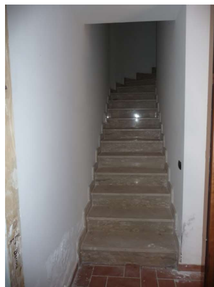
Foto 74 = vano scala da p.sottotrada a p.t.
