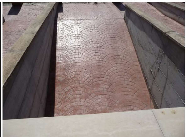
Foto 39 = rampa accesso garage
