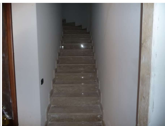
Foto 31 = vano scala da p.sottotrada a p.t.
