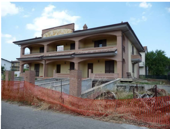
Foto 4 = fronte strada e lato sud
