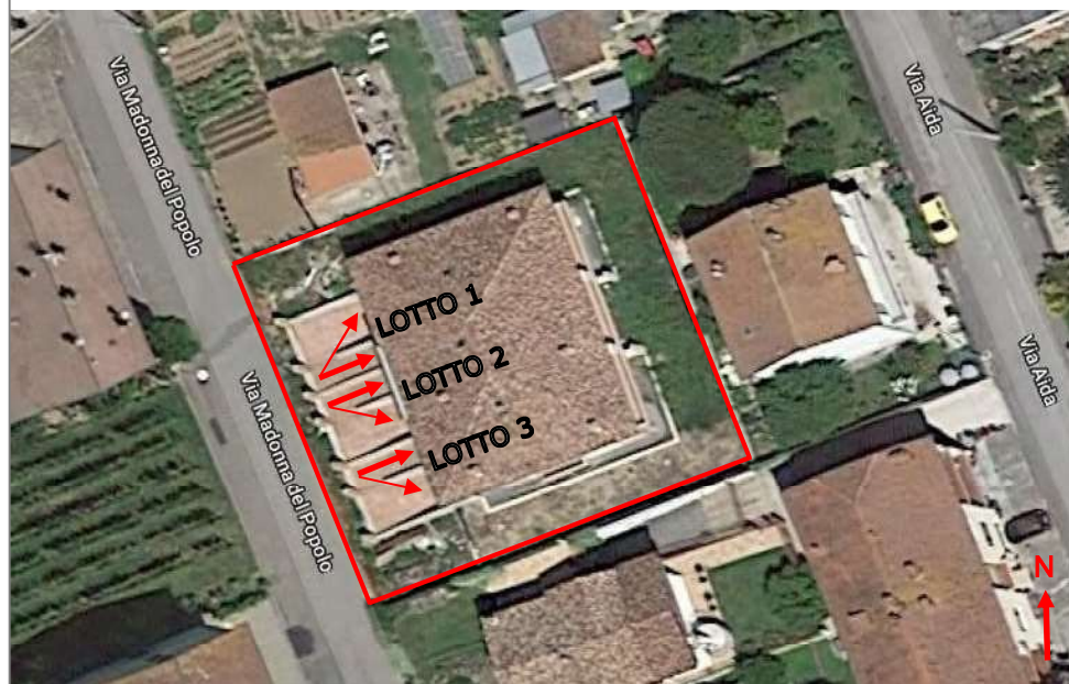
FOTO AEREA – LOCALIZZAZIONE
