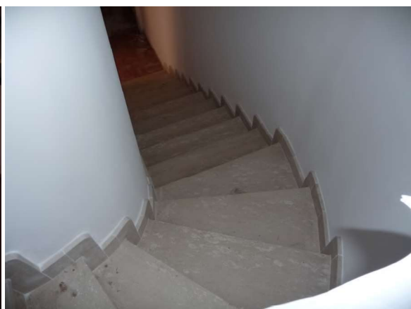
Foto 52 = vano scala da p.sottostada a p.t.
